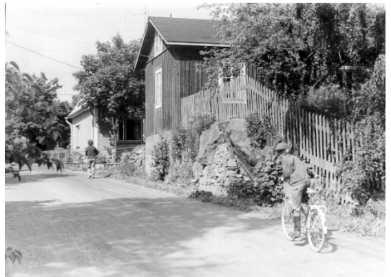
Tilanne on pysynyt tontin kohdalla ennallaan lukuun ottamatta linjalle päädyn takana olevaa puuta.
