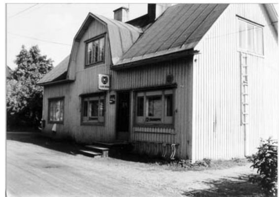
Paikalla ollut rakennus 1970-luvulta.
