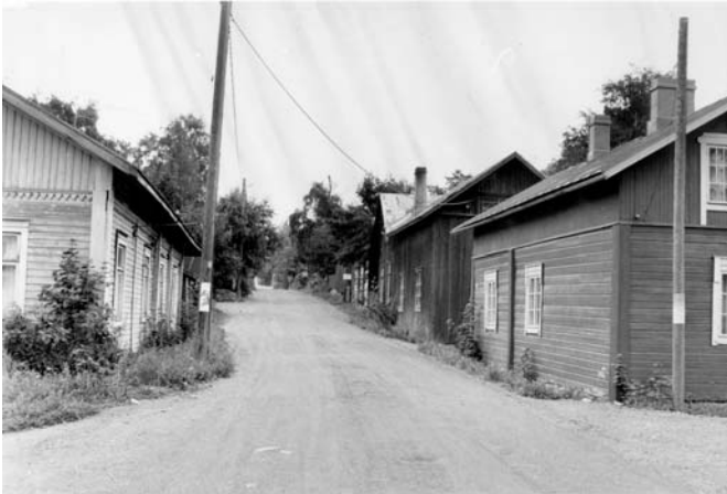
II linja on parannettu sorapintaiseksi. Avokallio on poistettu. Kapeat nurmikaistaleet jatkuvat yhtenäisinä linjan molemmin puolin. Oikeanpuoleisen ensimmäisen rakennuksen kohdalla linjan pinta on noussut liian korkeaksi suhteessa rakennuksen perustuksiin. Linjaa on tasattu tässä kohdin myös linjan suhteen poikittaisen korkesueron poistamiseksi. Asuinrakennuksen injalle tulevaan julkisivuun kuuluvat ikkunat. Kuva lounais-Hämeen museo.
