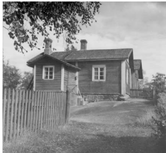
Vanhastaan tonteilla näkyvät avokalliot ja säleaita sovitetaan maaston mukaan ilman näkyviä porrastuksia. Perustuksissa käytetty luonnonkivi sitoo rakennuksen avokallioon. Luonnonnurmikukkinen liittyy piha-alueiden perustason laajaksi kokonaisuudeksi. Kuva Lounais-Hämeen museo.
