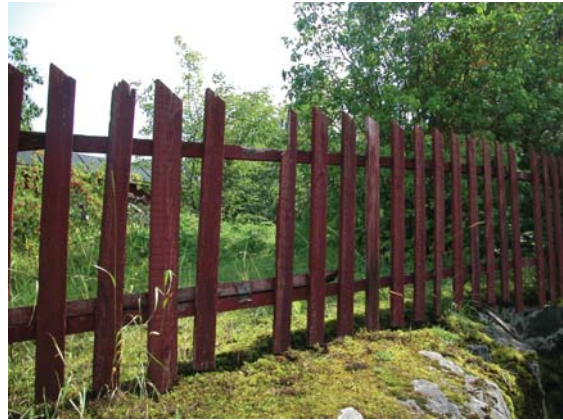
Kalliomäen alueella yleisesti käytetty harva säleaita on sovitettu maaston mukaan kulkevaksi usein ilman porrastuksia. Kuvassa yhteen suuntaan viistottu säleaita.
