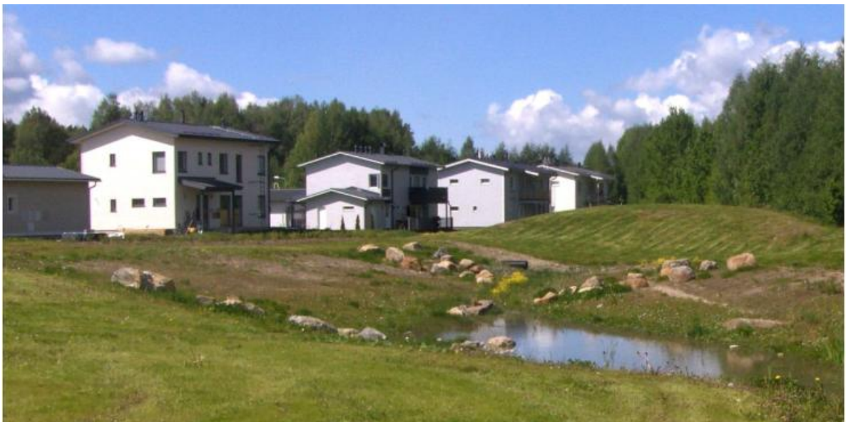
Kuva 5.5. Rambollin suunnittelema hulevesien luonnonmukainen viivytyalue Vaarinmaalla, Kangasalla. Kä-sittelyalueella yhdistyy pysyvän veden alue ja ympäröivä tulvaniittyalue.
