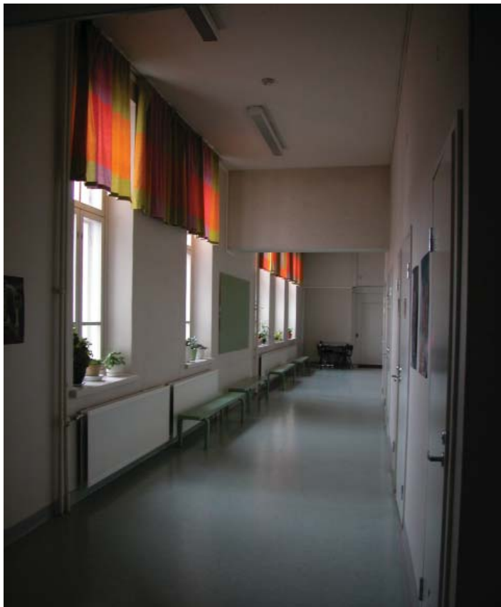
KÄYTÄVÄ ENSIMMÄISESSÄ KERROKSESSA VANHAN OSAAN JA VUODEN 1923 LAAJENNUKSEN VÄLILLÄ.
