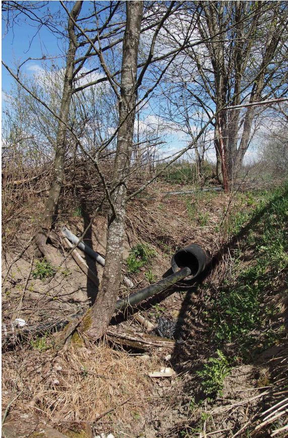
Kaupungin sadevesiviemärin purkukohdassa on osin maasto syöpynyt ja vesi ohjataan jokeen asti putkella.
