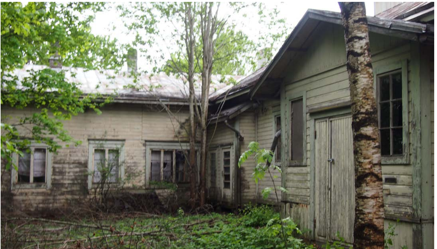
Sama rakennus tyhjillään keväällä 2017.
